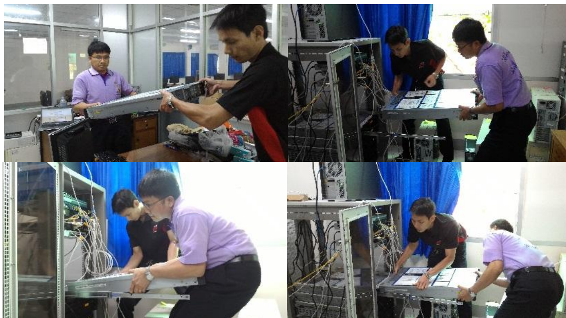
แผนภาพที่ 4.21 การประกอบเครื่องแม่ข่ายเข้าสู่บรรจเครื่องแม่ข่าย
