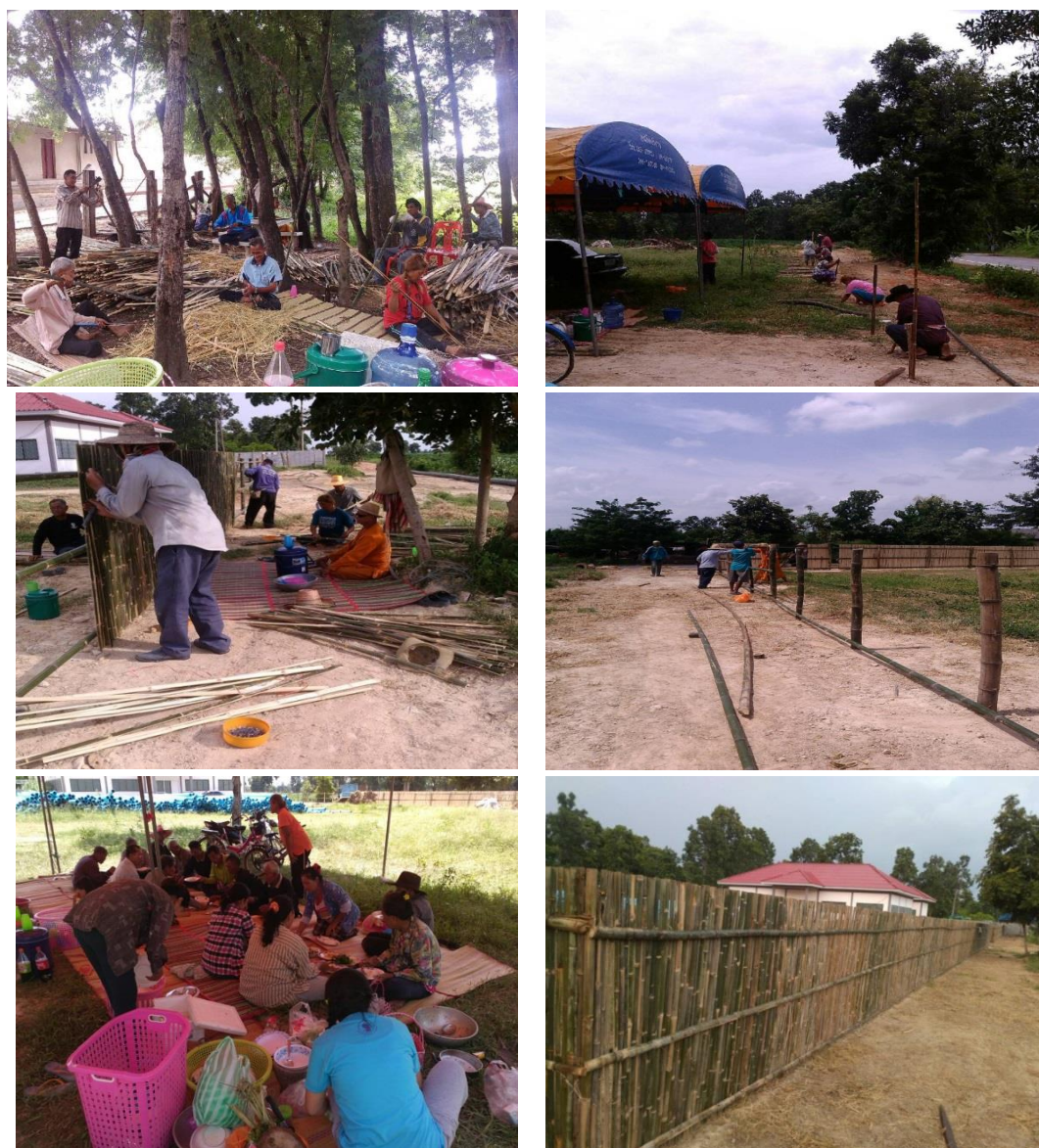
ภาพที่ 4.28 การก่อสร้างรั้วไม้ไผ่
