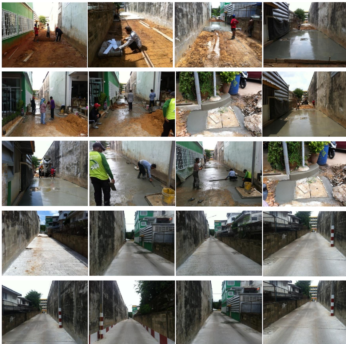
ภาพที่ 147 ภาพการดำเนินการก่อสร้างปรับปรุงทางเข้าใหม่บริเวณถนนมะลิวัลย์ (ต่อ)
