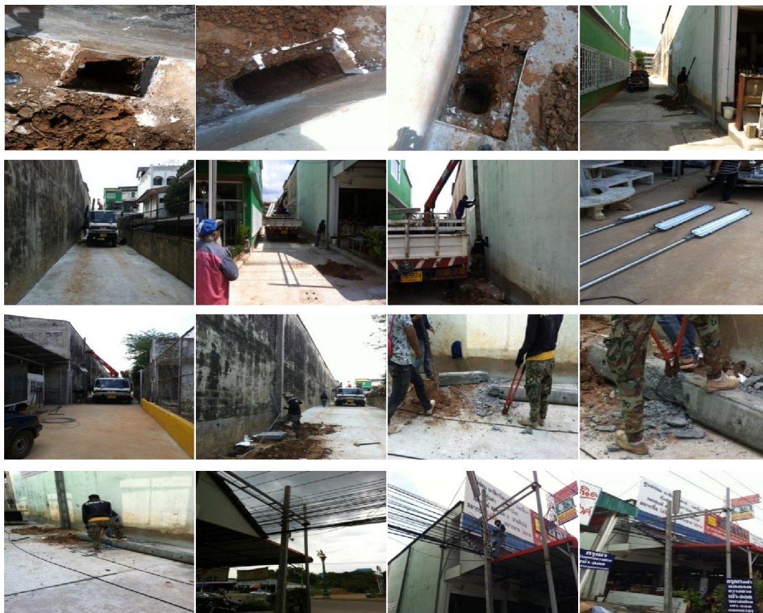
ภาพที่ 149 งานติดตั้งไฟส่องสว่างถนน (วันที่ 29 พฤษภาคม และ 5 มิถุนายน 2556)
