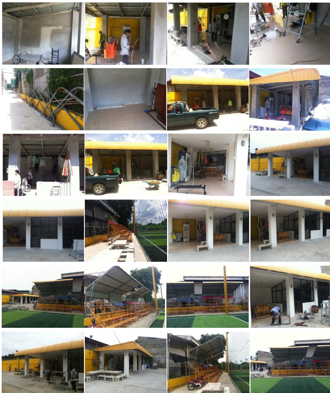
ภาพที่ 153 ภาพถ่ายก่อสร้างหลังคาอาคารอเนกประสงค์สนามหญ้าเทียมเพิ่มเติมและปรับปรุงร้านขายของใหม่
