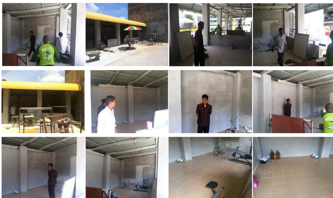
ภาพที่ 154 ภาพก่อสร้างอาคารห้องฝ่ายพัฒนากิจการนักเรียน นักศึกษา ใหม่
