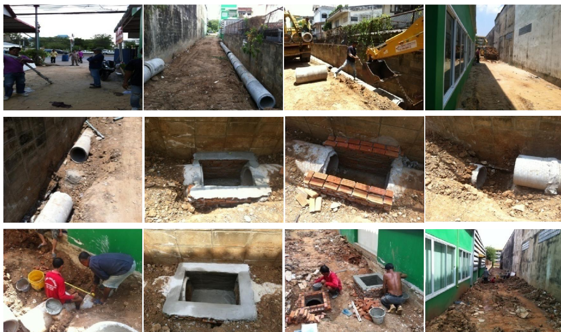
ภาพที่ 120 การปรับปรุงทางเข้าใหม่บริเวณถนนมะลิวัลย์ของวิทยาลัยฯ (ระหว่างการทำลงดำเนินการ)
