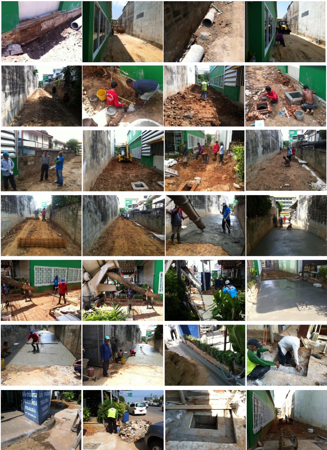
ภาพที่ 146 ภาพการดำเนินการก่อสร้างปรับปรุงทางเข้าใหม่บริเวณถนนมะลิวัลย์ (วันที่ 1 พฤษภาคม - 1 มิถุนายน 2556)
