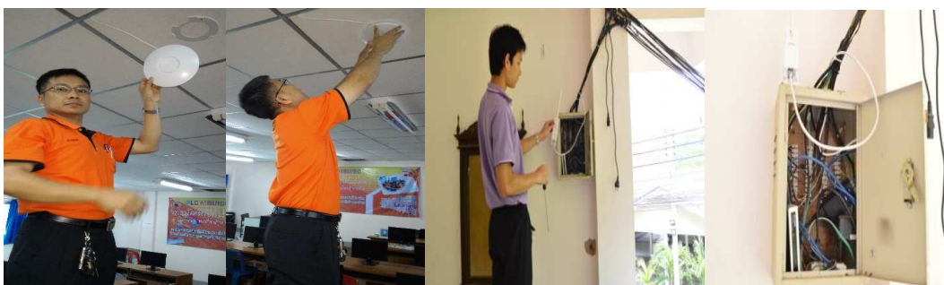
ภาพที่ 4.12 การจัดหาและติดตั้งเครือข่ายไร้สาย (Access Point)
