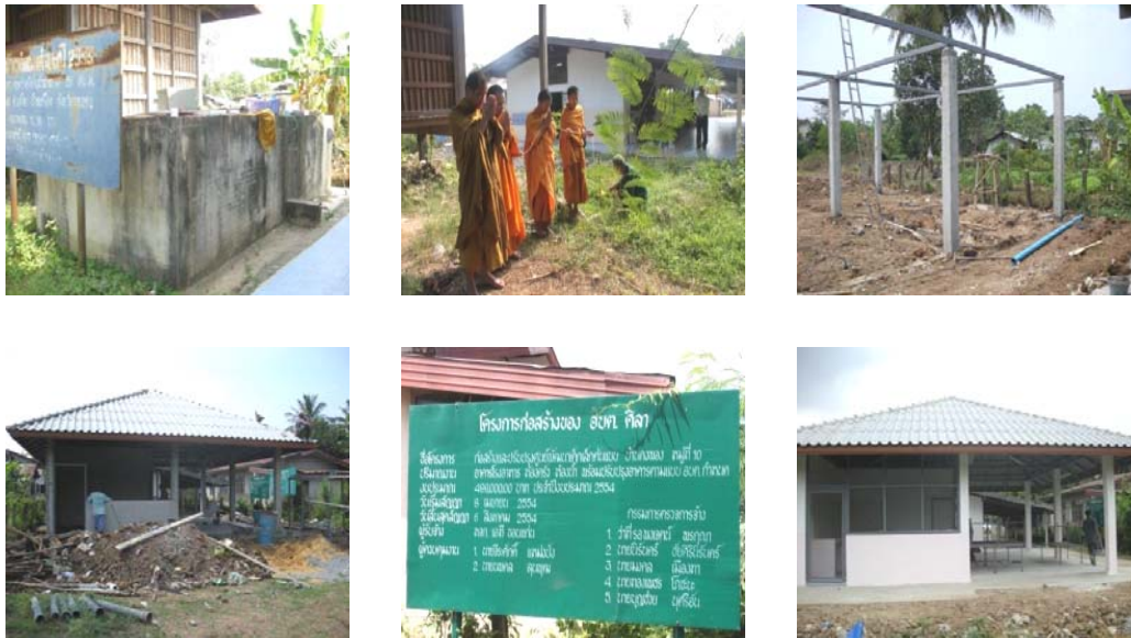
ภาพที่ 72 การก่อสร้างโรงอาหาร
